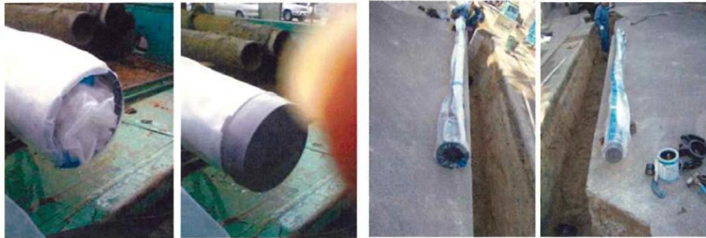
(キャップ取り付け) (キャップ取り付け) (受口処理) 据付前 (挿し口処理) 据付前
